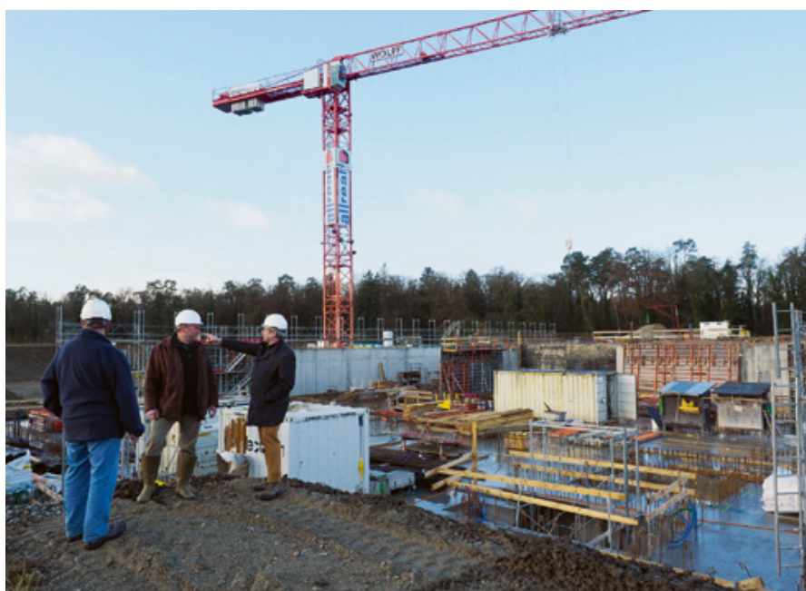
Die Bauarbeiten der Jagdschiessanlage Widstud sind weit fortgeschritten. Einer Eröffnung Mitte 2023 steht nichts im Weg.
